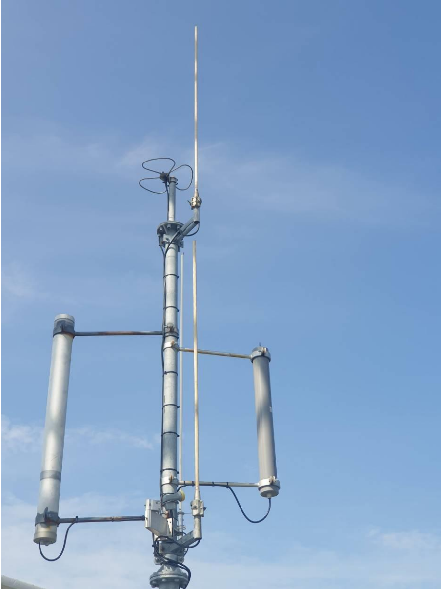
De oude situatie van PI2HLM in juli 2023, waar het DATV Klaverblad nog op de top staat van de N-O mast. Ter hoogte van het Klaverblad staat de TX-antenne van PI2HLM met direct daaronder in lijn de RX-antenne. Beide antennes zijn van het type Kathrein K7516211
