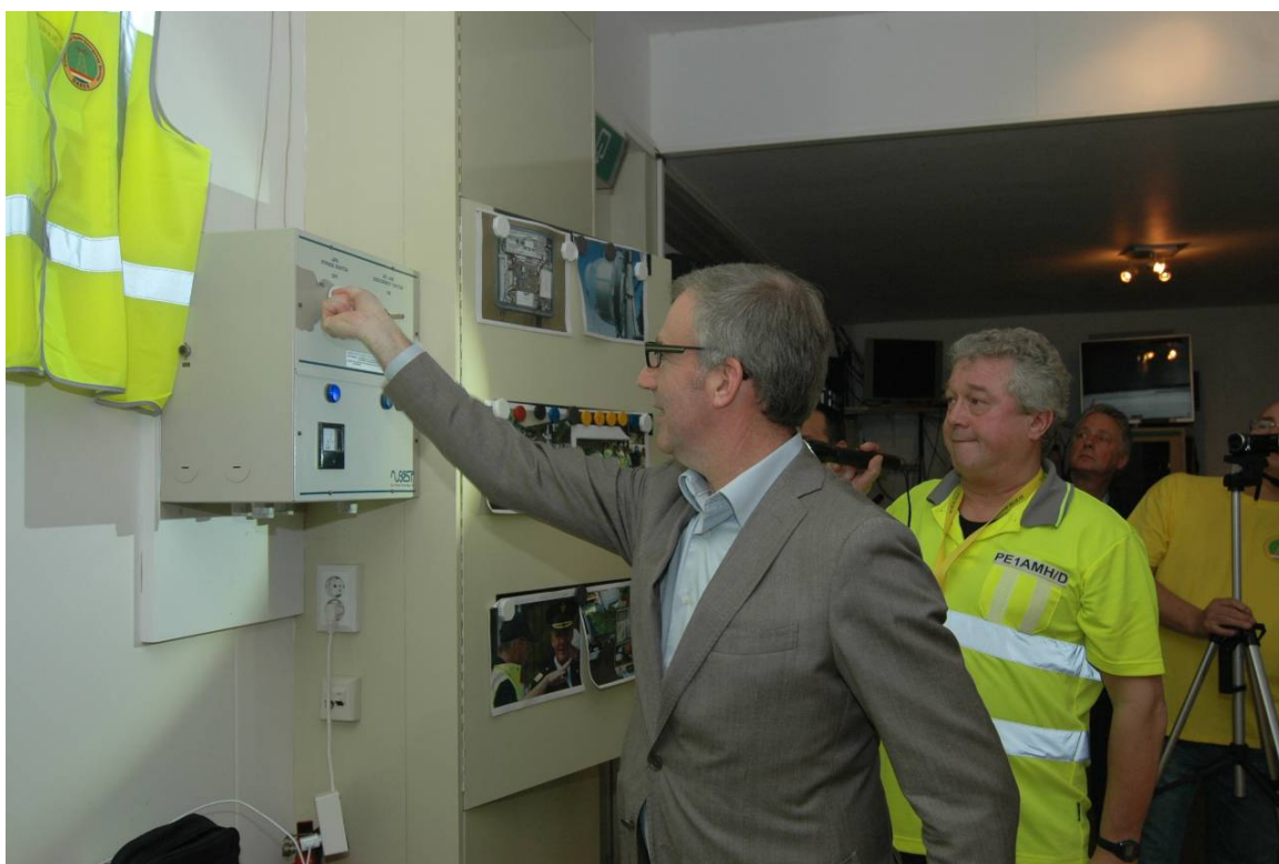
Met het omzetten van een schakelaar schakelde burgemeester P. Heiliegers om naar de noodstroom-voorziening
