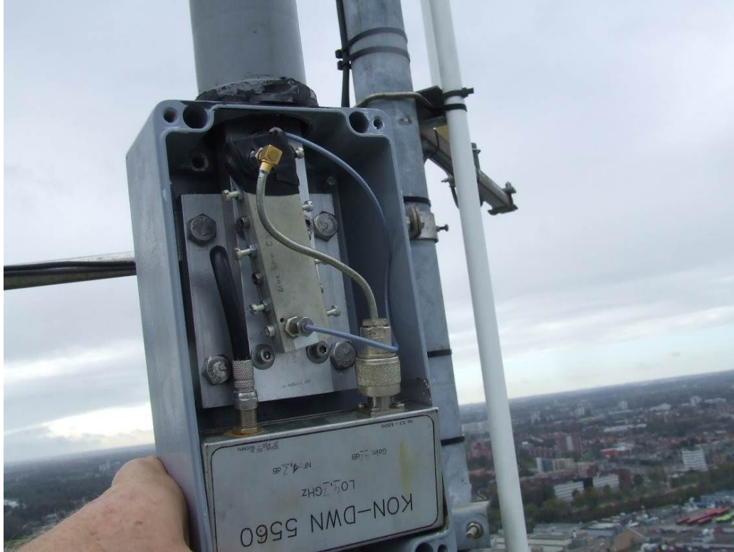
Het ingebouwde banddoorlaatfilter van de 5780 MHz antenne-ingang (6 cm band)
