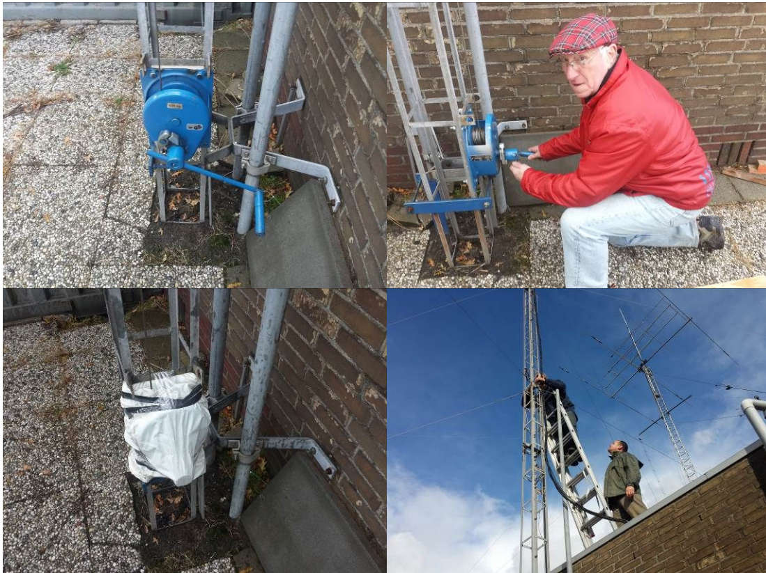
Montage van de nieuwe lier op de schuifmast en het tuien van deze mast
